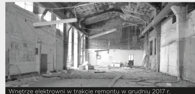
Wnętrze elektrowni w trakcie remontu w grudniu 2017 r.
