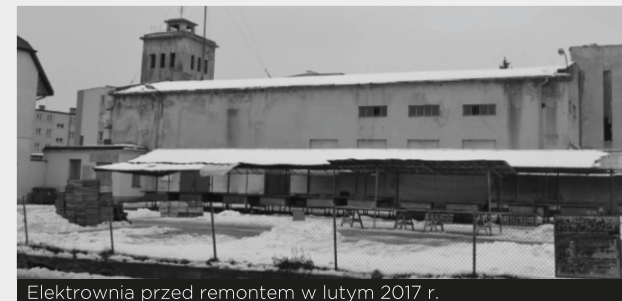
Elektrownia przed remontem w lutym 2017 r.
