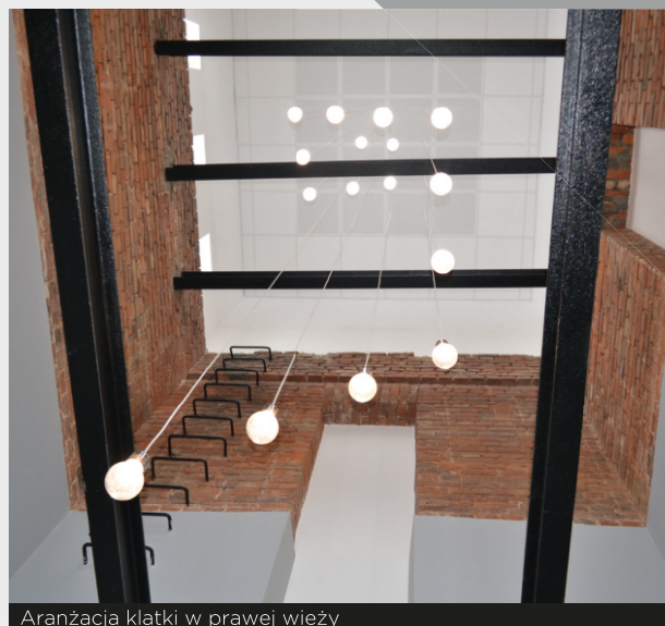
Aranżacja klatki w prawej wieży
