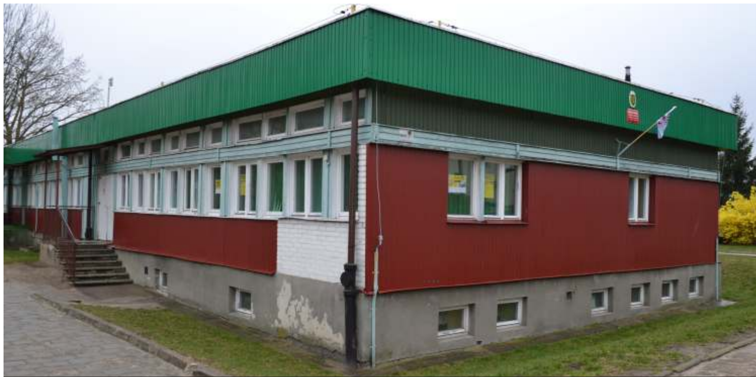
Realną perspektywą rozpoczęcia budowy szkoły jest wiosna 2020 r.
