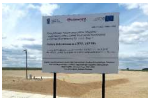
Od 28 czerwca ZGK posiada pozwolenie na prowadzenie instalacji do składowania odpadów obejmujące nowo wybudowaną kwaterę nr 3.
